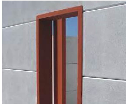
شکل ۲- نصب نعل درگاه و بازشوها
